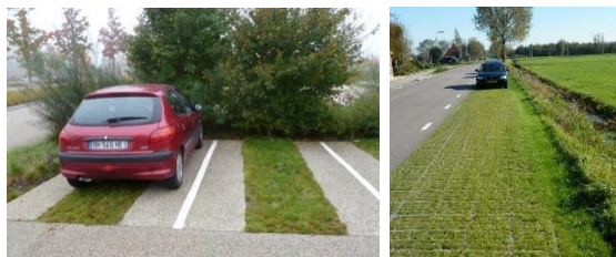
Bandes enherbées et stationnement avec système alvéolaire
